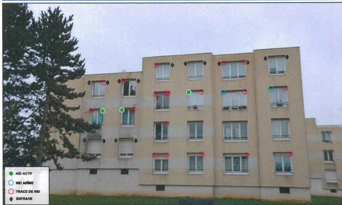
Bâtiment 16, Façade Est
