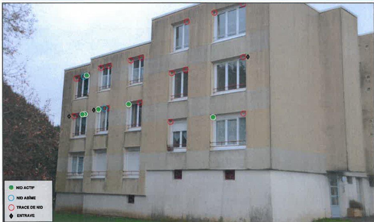
Bâtiment 18, Façade Ouest
