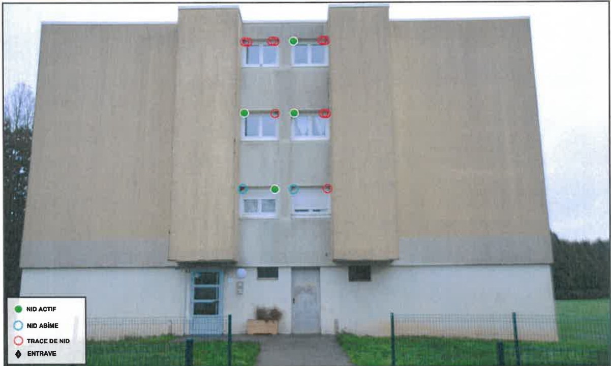
Bâtiment 18, Façade Sud
