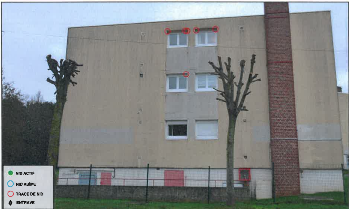
Bâtiment 14, Façade Sud-Ouest
