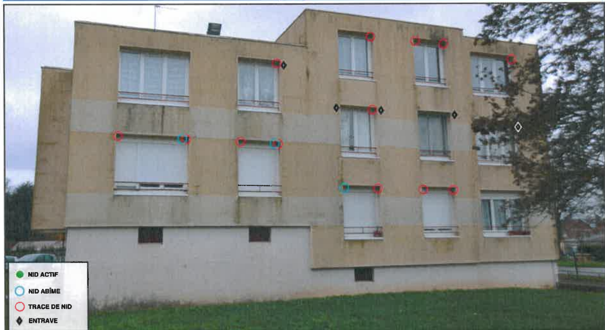
Bâtiment 14, Façade Nord-Ouest
