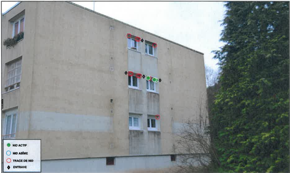
Bâtiment 18, Façade Nord
