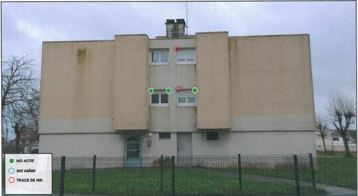
Bâtiment 14, Façade Nord-Est
