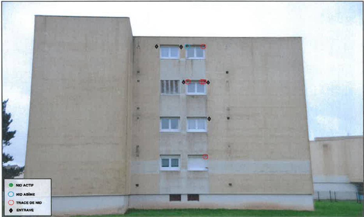
Bâtiment 16, Façade Nord
