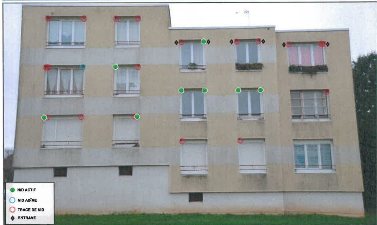
Bâtiment 18, Façade Est
