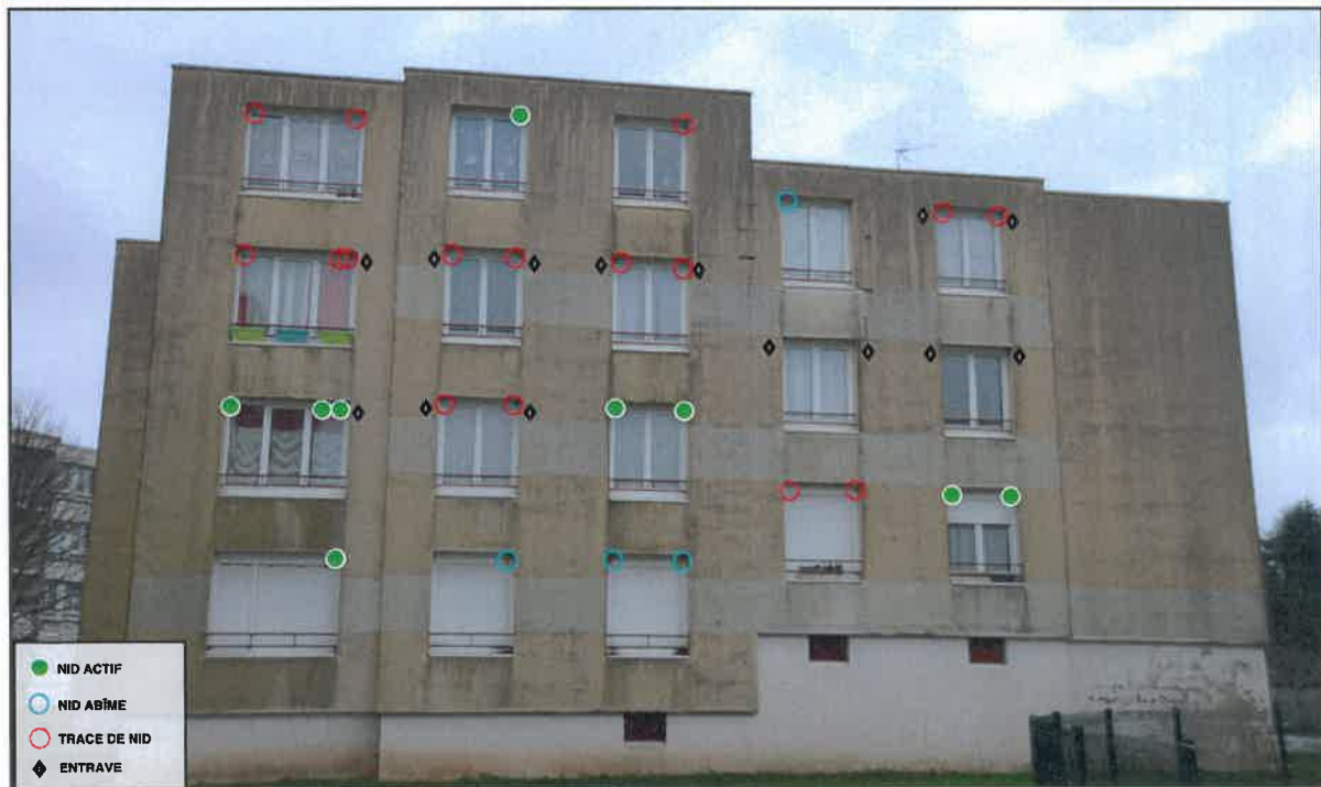
Bâtiment 16, Façade Ouest
