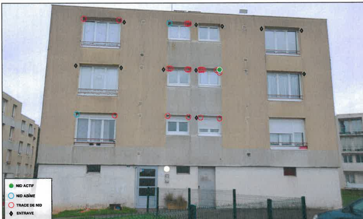
Bâtiment 16, Façade Sud
